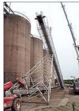
Montage der Tragsockel für einen Turbinenprüfstand für Flugzeug – Strahltriebwerke in ca. 13m Höhe.
